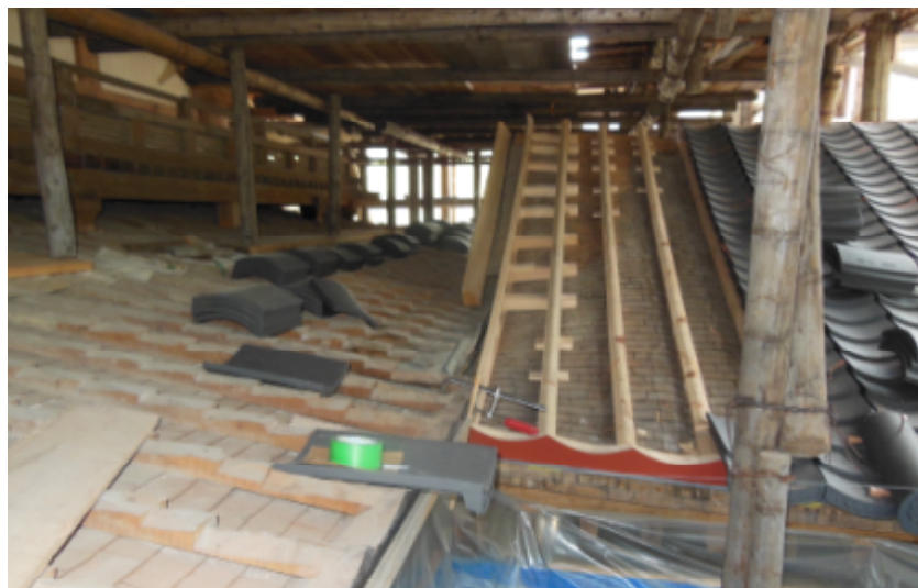
平等院鳳凰堂の修理現場。いつもと違うものが見える
