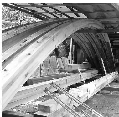
写真(右) 白根工務店作業場 アーチ制作中
